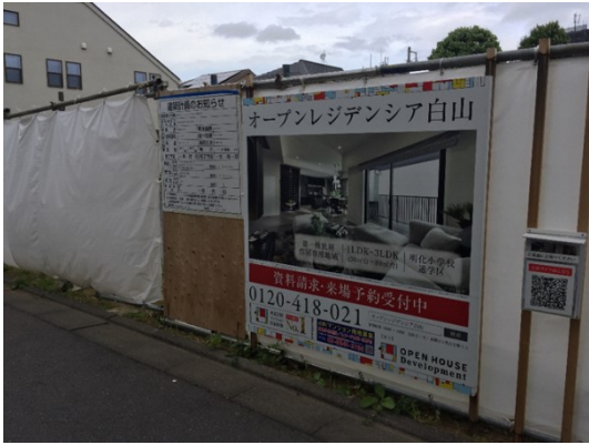
マンション建設予定地(白山四丁目)
