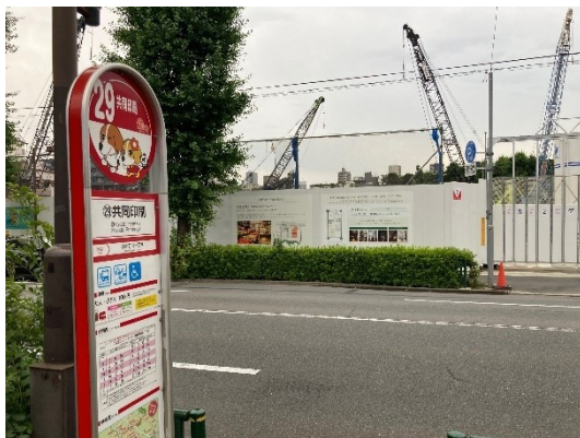
マンション建設工事現場(小石川四丁目)
