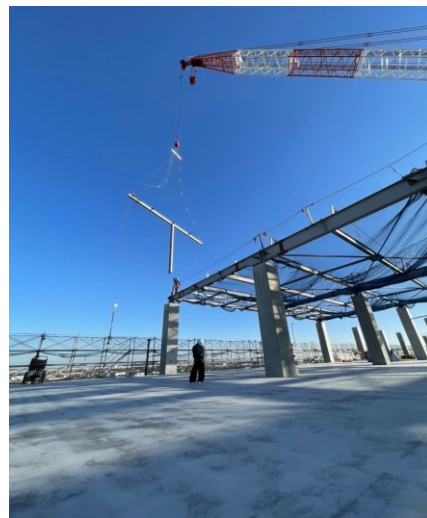
クレーン作業中
