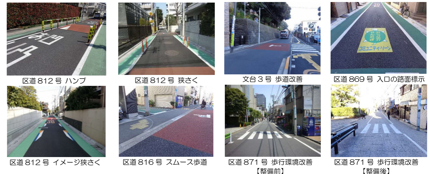
区道 812 号 ハンブ 区道 812 号 狭さく 文台 3 号 歩道改善 区道 869 号 入口の路面標示 区道 812 号 イメージ狭さく 区道 816 号 スムース歩道 区道 871 号 歩行環境改善【整備前】 区道 871 号 歩行環境改善【整備後】
