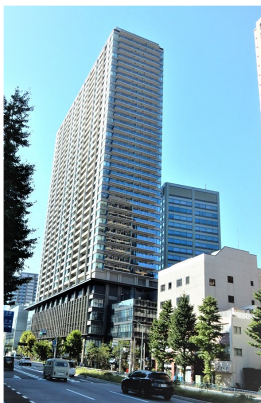
春日・後楽園駅前地区 市街地再開発事業 北街区
