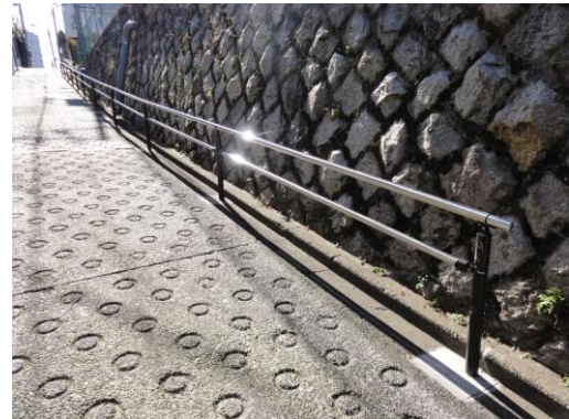
急な坂道への手すりの設置
