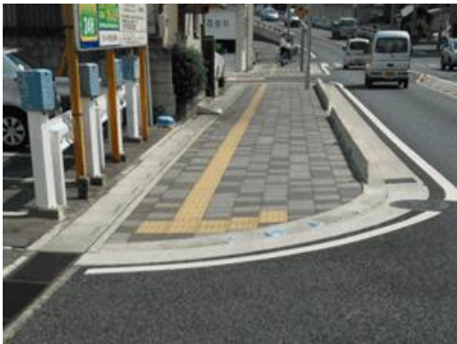
バリアフリー化された歩道
