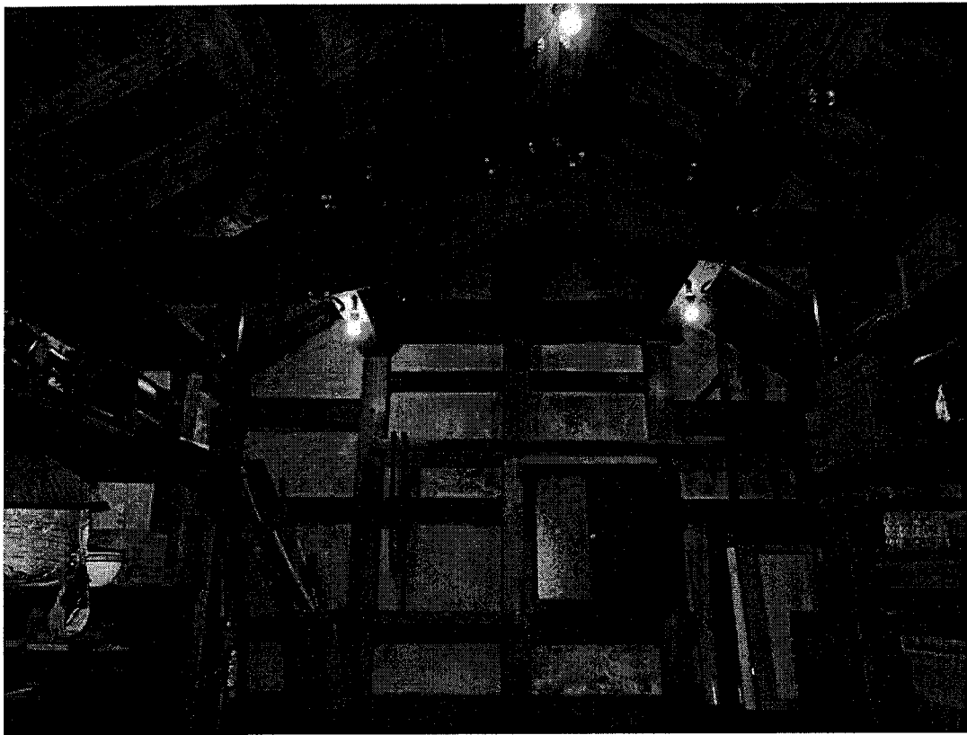
旧伊勢屋質店 土蔵2階内観 小屋の二重梁、梁間中央の中引梁はケヤキ材を使用している
