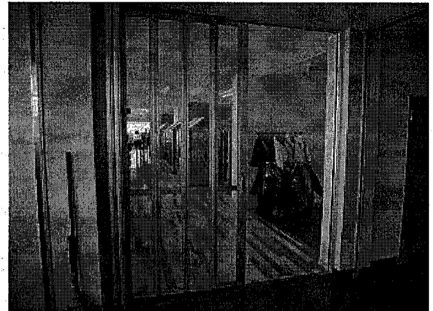
北側外壁はウレタンを30mm吹き付けて断熱。廊下に扉を設け、学年・暖房時の区画に利用。
