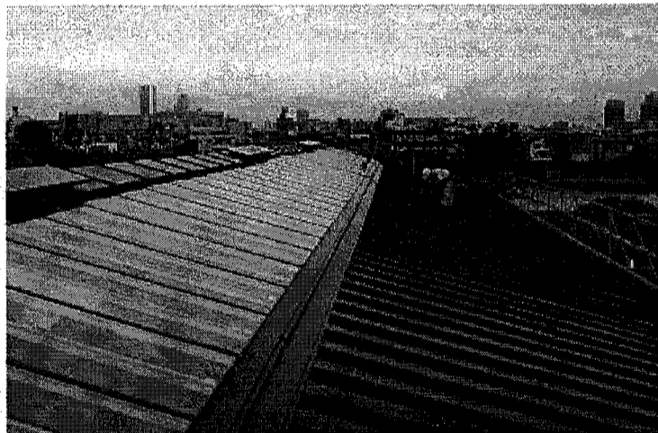
太陽熱利用空気式低温床暖房システム(OMソーラー)を導入した体育館の屋根。既存屋根仕上げの上に断熱して、新規の集熱屋根を設置。
