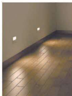
■足元灯の設置
