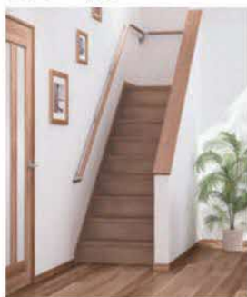
■手すりの設置
