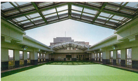
⑧ 7階プール室 (25m プール・6コース) 夏季以外は人工芝を敷き、多目的な用途に使用します。屋根は可動式となっています。
