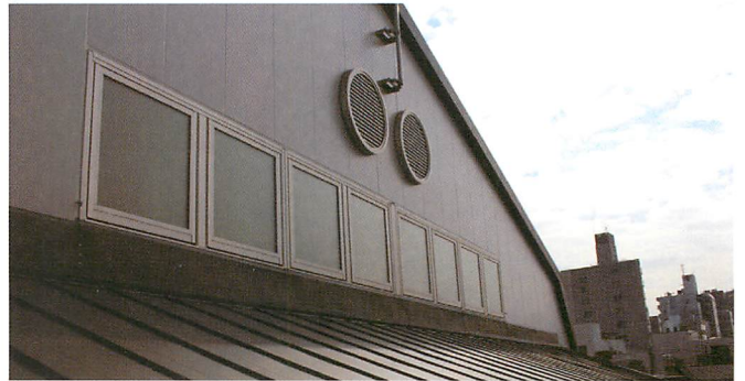
④全自動換気システム アリーナには、外部の天候により自動的に開閉する換気窓を設置しています。
