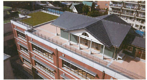
③ 5階会議室・屋上緑化 会議室は、離れ風に配置され、東棟に廊下でつながるとともに、屋上テラスは緑化しています。
