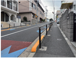
急な坂道への 手すりの設置
