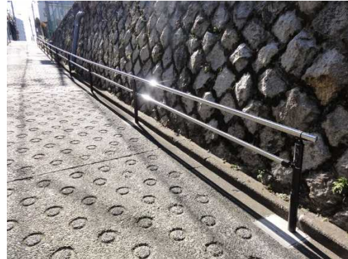
急な坂道への手すりの設置
