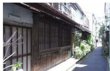
路地沿いに建つ木造の長屋(根津)
