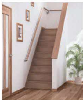
■手すりの設置
